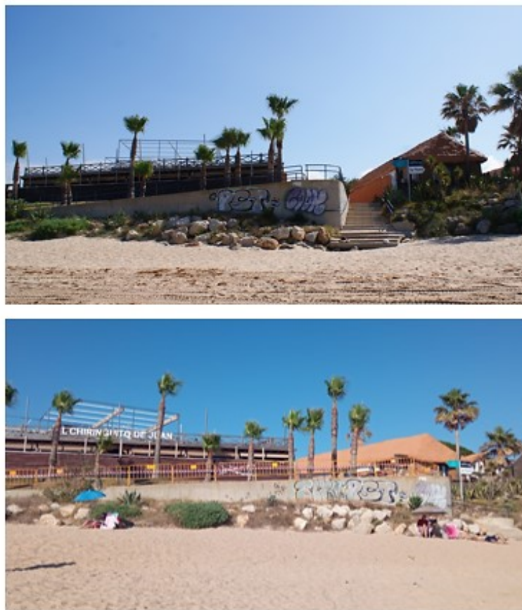
Figura 51. Imagen superior (acceso principal de El Calentón de Zahora con barandillas en la temporada 2020) e imagen inferior (mismo acceso sin barandilla temporada 2021). Fuente: Fotografías tomadas por la autora de la investigación.
