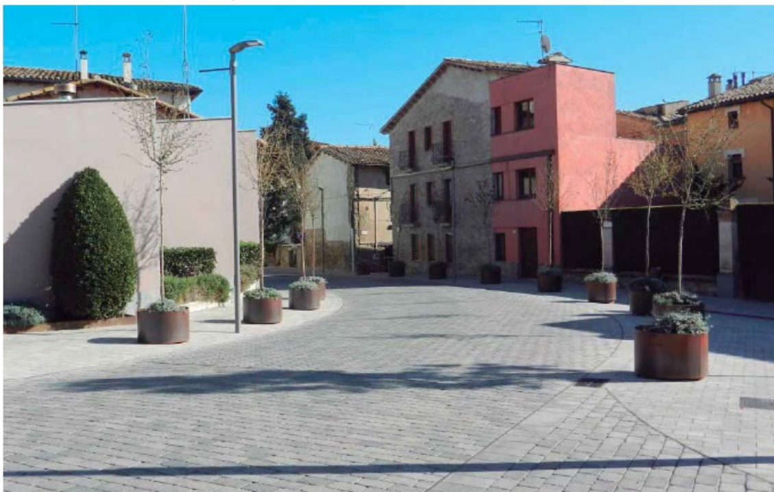
Figura 5. Ejemplo de tratamiento de Travesía
